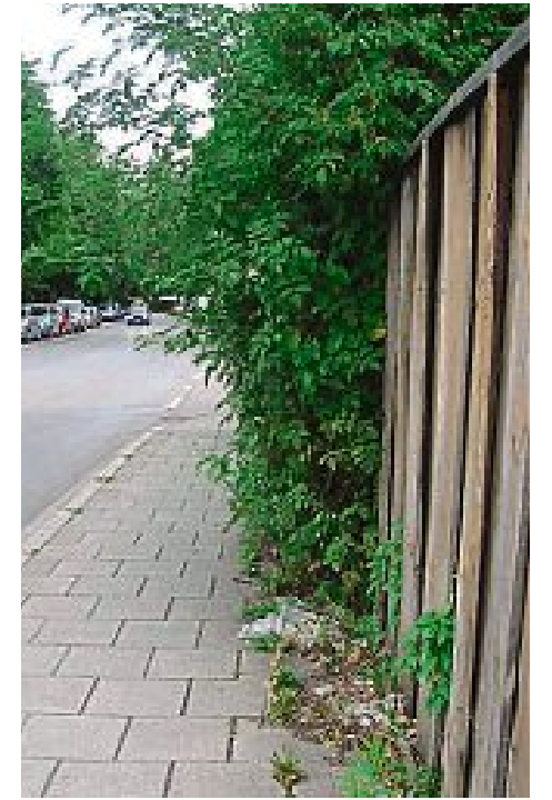
Abb. 5: Die Sicht im Einmündungsbereich zur Querstraße ist durch den Überwuchs behindert, auf dem Gehweg befindet sich zudem Unkraut.
