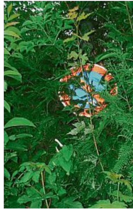
Abb. 4: Durch den starken Überwuchs mit Pflanzen ist die Beschilderung für keinen Verkehrsteilnehmer einwandfrei zu erkennen.
