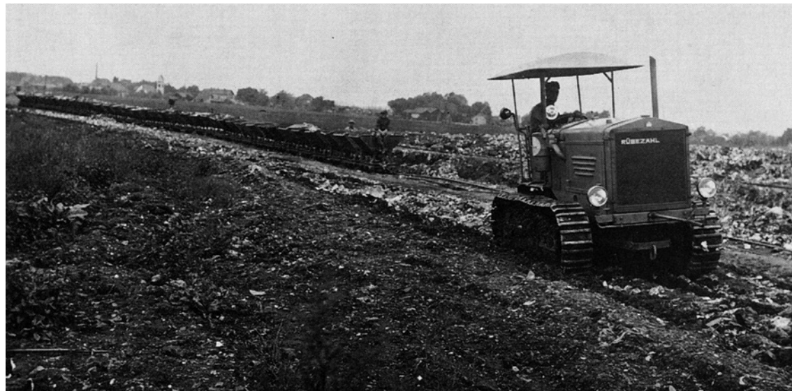
Restmülldeponierung auf der Planie in den 1940er-Jahren. Nach dem Aufschütten des Mülls wurde dieser mit der Planierraupe eingeebnet.
