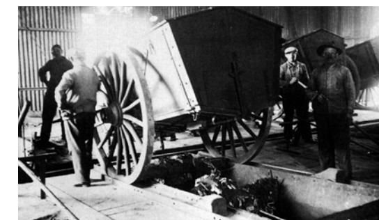
Harritschwagen beim Entladen. Der Inhalt fiel direkt in eine Schüttelrinne, die den Grobmüll vom Feinmüll trennte.
