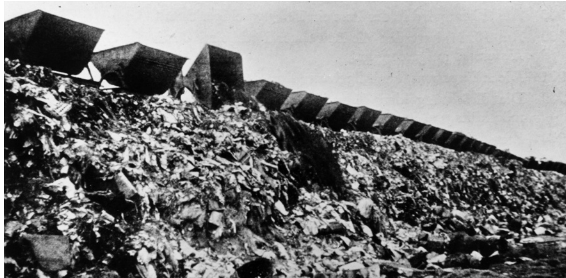
Gelände der Planie mit Feldbahnen. Nach den Sortierungsvorgängen wurde der restliche Müll auf das Gelände der Planie gefahren.
