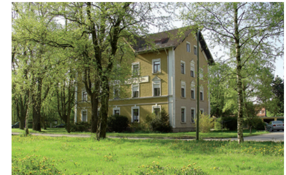
Verwaltungsgebäude auf dem Gut Harbeck.
