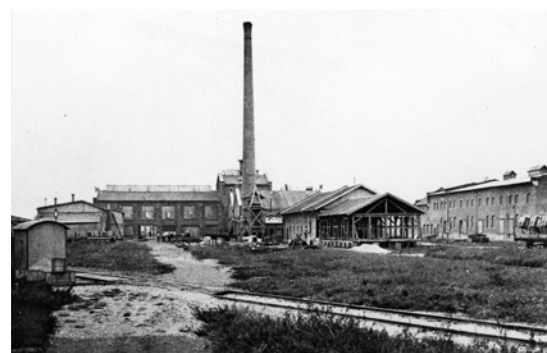
Verwertungsanlage, im Vordergrund die Bahngleise.
